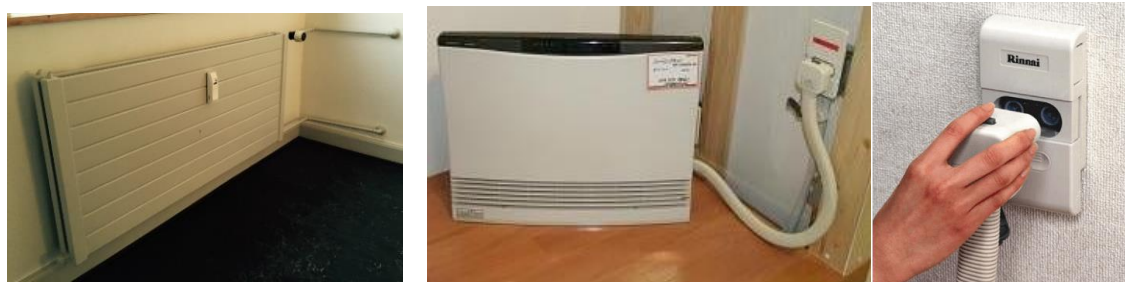
図 3-5 温水パネルヒーター(左)と、温水ルームヒーター(中)、温水コンセント(右)
