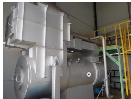
写真 3-2 重油ボイラー（左：本体、右：蒸気ヘッダー管） 写真 3-3 脱臭炉
