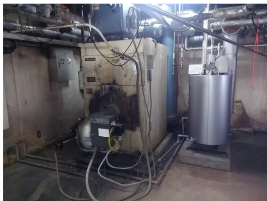
写真 3-5 重油ボイラー①と貫流ボイラー
