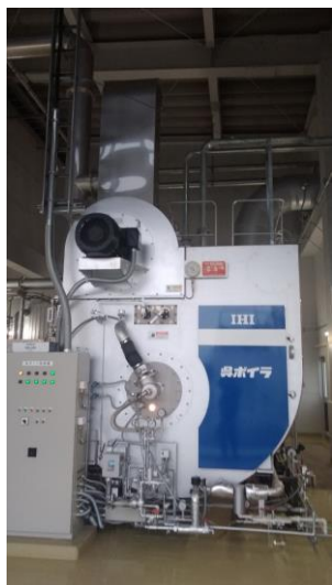
写真 3-2 重油ボイラー（左：本体、右：蒸気ヘッダー管） 写真 3-3 脱臭炉
